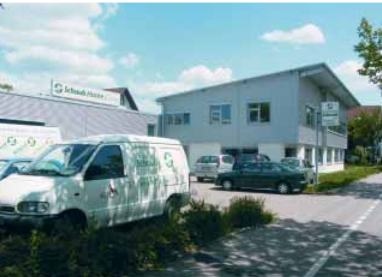
Zentrales Verwaltungsgebäude der Franz Schaub GmbH.
